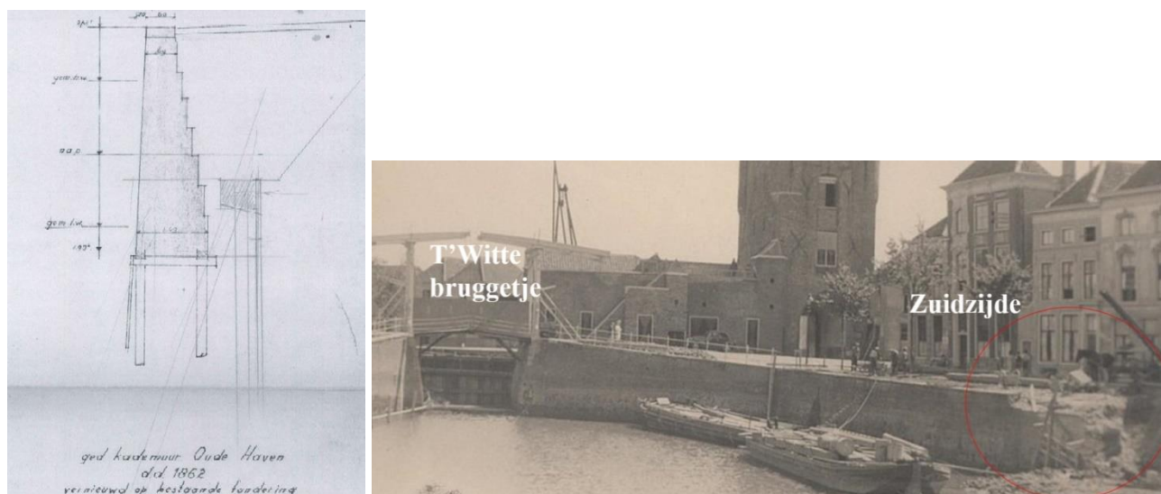
Fig. 2. Tekening uit 1862, waarbij in het onderschrift aangegeven wordt dat de bestaande fundering hergebruikt wordt (links) [1]; Ingestorte kade aan de zuidzijde in 1949 (rechts).
