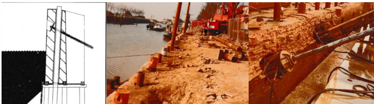
Fig. 6. Herstelmethode Nieuwe Haven 1981; herstellen metselwerk, aanbrengen schroefpalen en nieuwe verankering.
